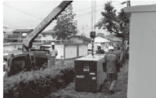
本部庁舎電源切替盤への発電機繋ぎ込み
