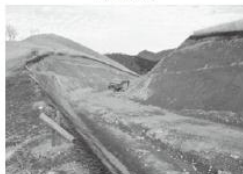
メガネ原道整備工事
