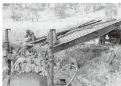
自走架柱橋による橋梁架設
