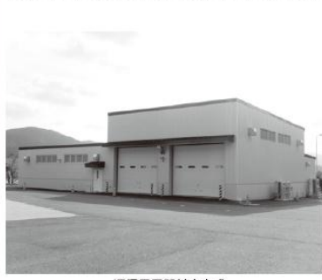
通信電子器材庫完成
