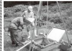
水槽内の泥の除去
