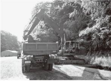
大分弾薬支処整備において重機を使用し溜舁の浚渫工事を実施
