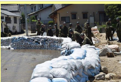
矢野地区土のう被覆（西特連）
