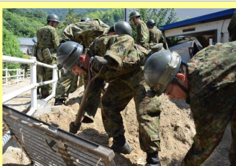
小屋浦地区応急復旧（42即機連）
