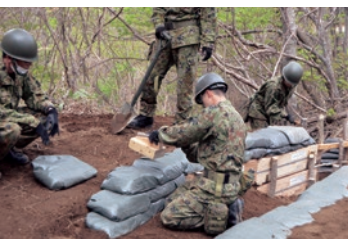
土のうの積み上げ
