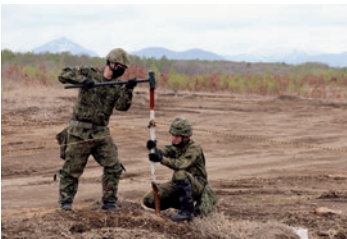
溜柵標示杭補修
