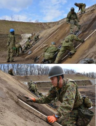
射場停弾部の整地作業 (第5高射特科中隊)
