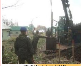
演習場門扉補修 (第5施設隊)
