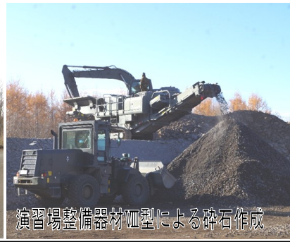
バケットローダによる積み込み
