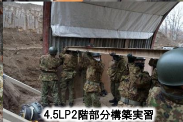
4.5LP2階部分構築実習
