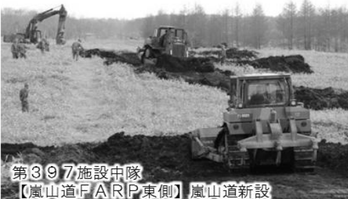
民生品のテンサー及びポリフェルトシートによる施工
