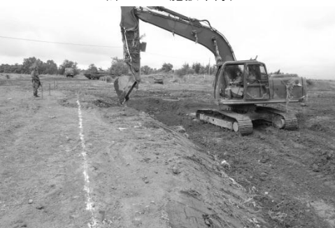
機動路の整備 (第342施設中隊)
