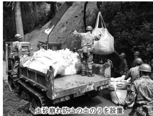
土砂崩れ防止の土のうを設置
