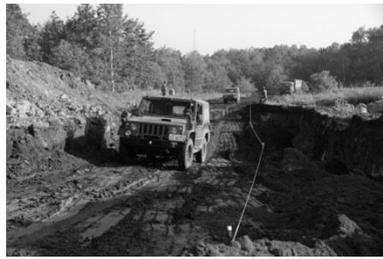
地隙を処理して車両を通過させる(第312施設器材中隊)
