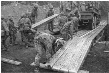
破壊された道路に自走架柱橋を架設(第312施設器材中隊)
