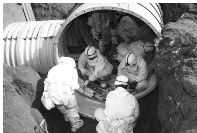
ライナープレートによる指揮所の構築
