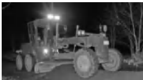
夜間整備（装輪道）
