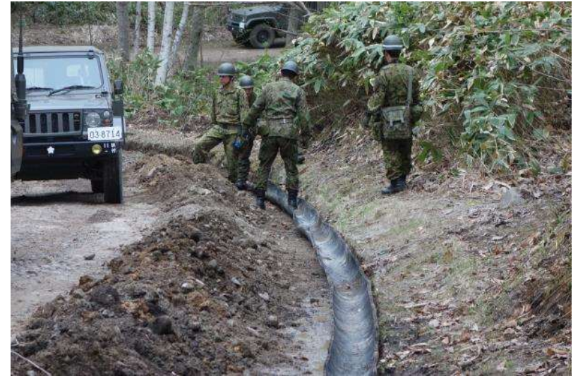
側溝に対するU字溝の設置
