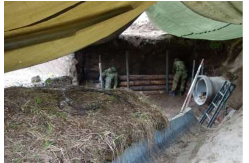
溜め枡の新設
