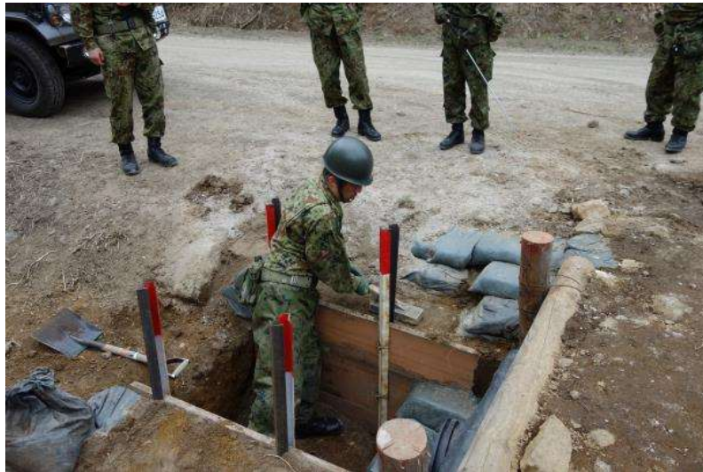
道路の浸水防止のため 溜め枅を整備
