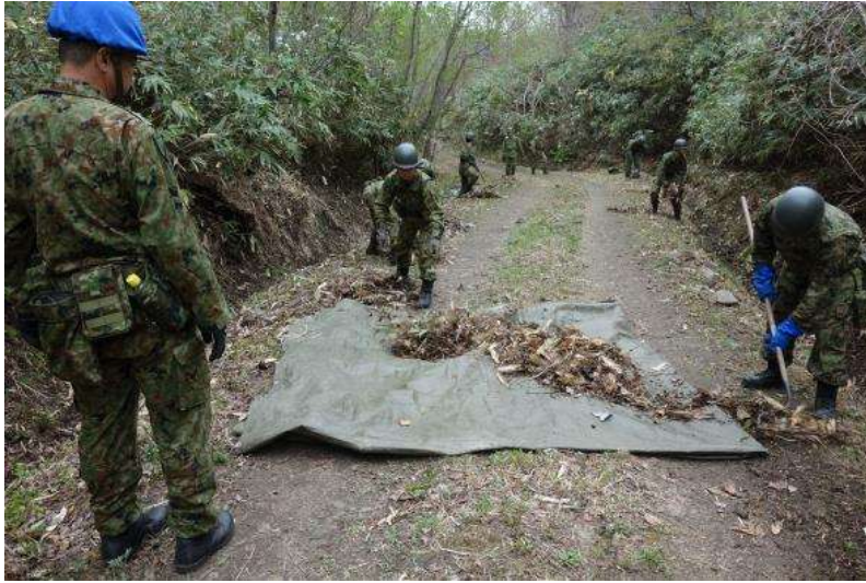
側溝の枯れ草の除去
