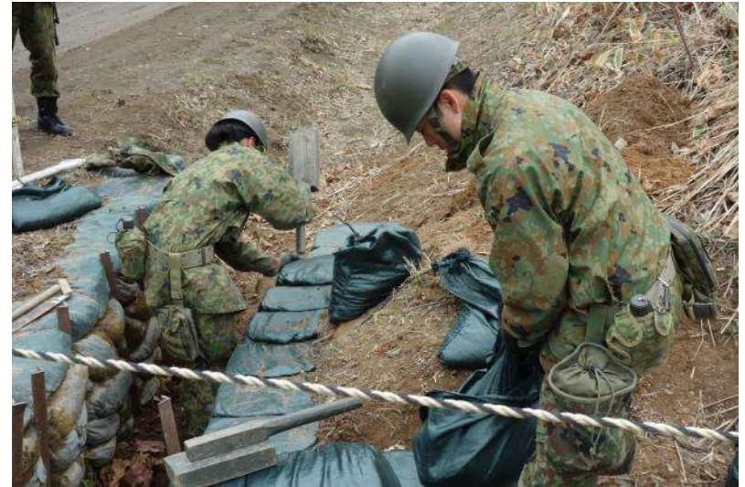
側溝に対する土のうの設置
