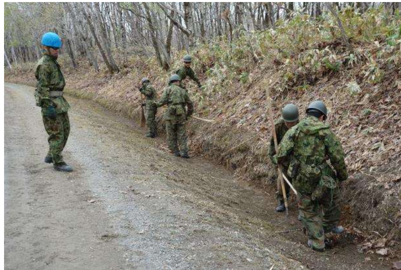
側溝の落ち葉等の除去
