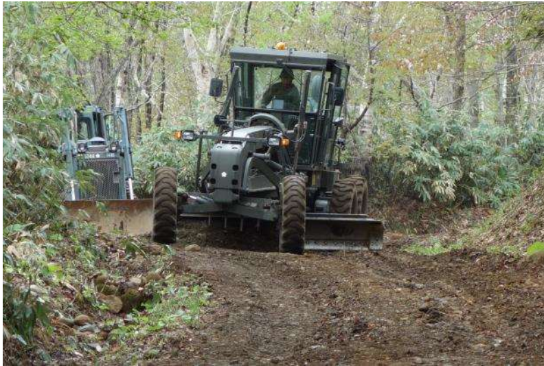
グレーダーによる道路整地
