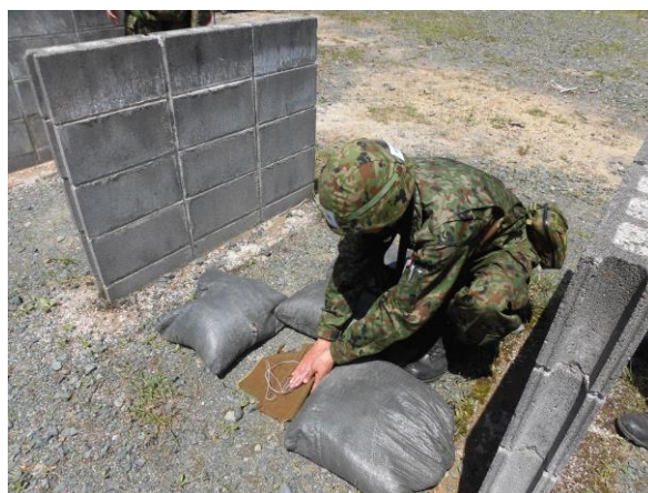
電気雷管導通点検
