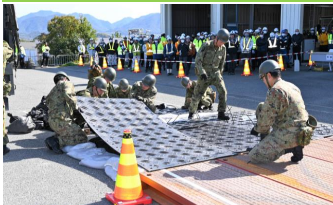
土のう袋を使用した道路段差の応急復旧
