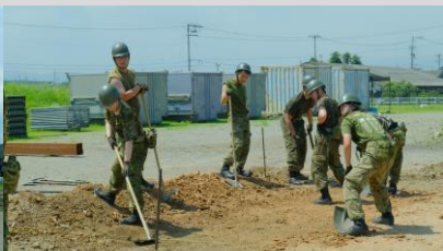
設置場所の水平化
