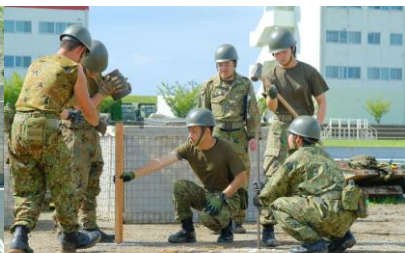
ソイルアーマー設置場所の経始
