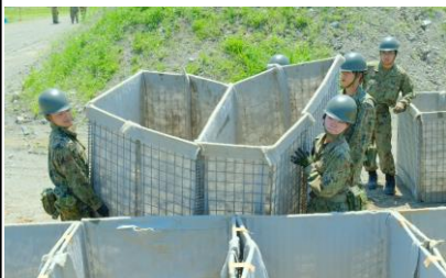
ソイルアーマーの構築
