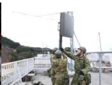
高知駐屯地屋上でアンテナ設置（高知）
