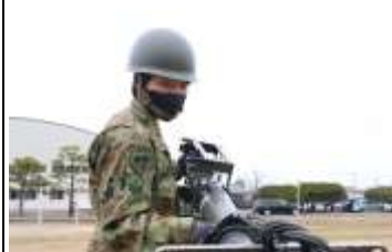
アンテナ建柱
