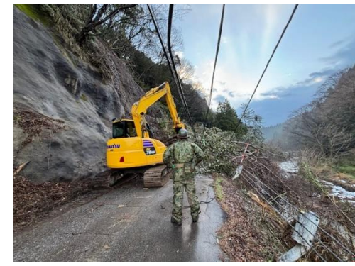
門前町鍛冶屋 道路啓開作業
