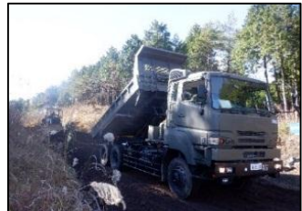
ダンプによる骨材運搬 (演習場定期整備)
