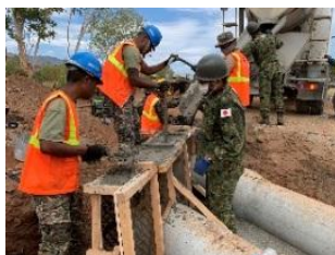
コンクリート打設を指導
