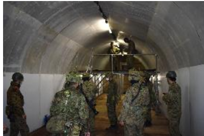
指揮所用掩蓋掩壕の構築 (第5施設群)
