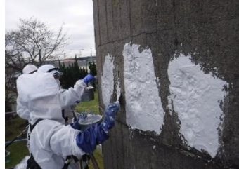
駐屯地高架水槽側面補修
