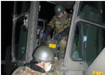
グレーダ駐車ブレーキ修理
