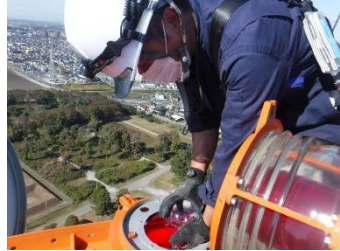
通信鉄塔航空障害灯交換
