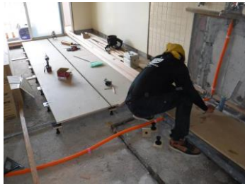
総和1号宿舍床等補修工事
