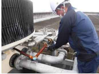
隊舎冷却塔補給水管補修
