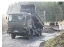
施設器材と連携した骨材卸下 (演習場定期整備)
