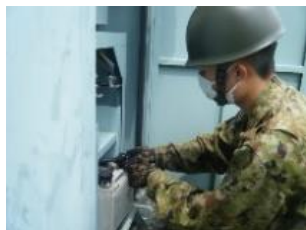
感電しないように細心の注意を払いバッテリー交換
