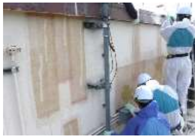
庁舎外壁補修
