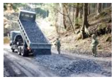
砕石の運搬・敷均
