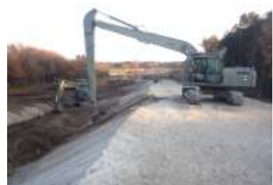
観測台取付道の構築(法面の整形作業状況)
