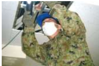
天井裏の配線作業をする隊員
