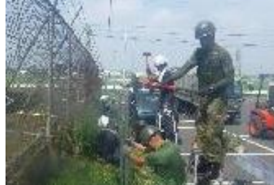
駐屯地外柵補修
