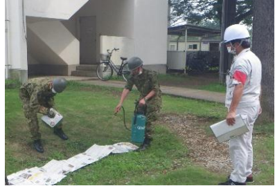
油流出防止作業
