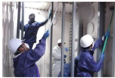
貯水槽清掃作業
