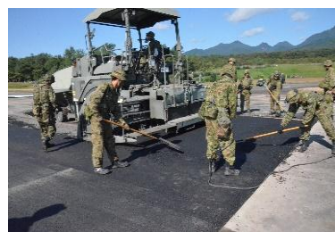
飛行場のAs舗装工事
