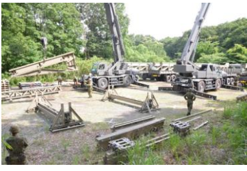
架設準備を行うクレーン
