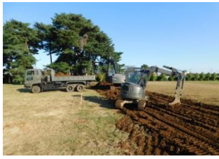
地盤整地作業の状況
