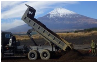
骨材を卸す特大ダンプ
