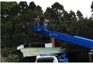
高所作業車を利用した倒木の除去
