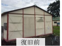
梱包発送所 壁鉄板、鉄骨柱破損
