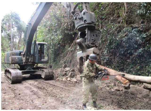
施設器材と人力による倒木の除去
