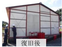
梱包発送所 壁鉄板、鉄骨柱破損
