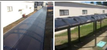
施工後 ← 施行前 アーケード屋根補修
