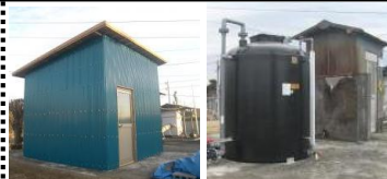
施工後 ← 施行前 給水所給水消毒薬剤貯留タンク小屋設置
