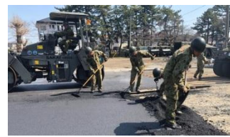
アスファルトを均す隊員
