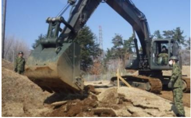
油圧ショベルによる表土掘削
