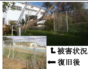
台風24号被害復旧作業（倒木による被害復旧）
