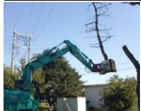
駐屯地樹木伐採作業（フアンチャザワルスによる伐採）
