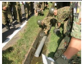
油流出対処訓練（土壌とパイプによる堰の構築）
