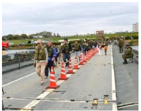
完成した浮橋を通行する来場者
