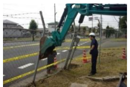
外柵応急復旧作業
