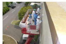
1号庁舎雨漏補修作業
