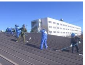
食堂屋根の塗装作業
