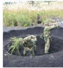
機関銃掩体構築
