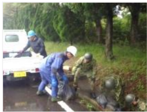
土壌による油流出対処
