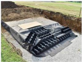
クロスウェーブ埋設
