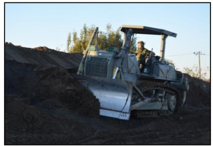
ドーザによる道路拡幅作業
