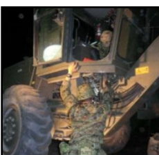
グレーダブレーキバルブインナーキット交換
