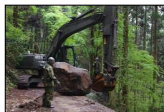
道路啓開作業
