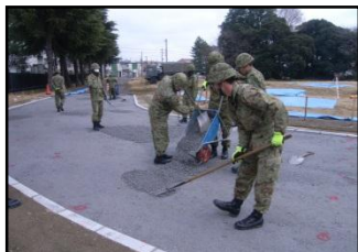
人力による上層路盤修正
