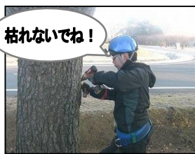
薬剤の注入作業
