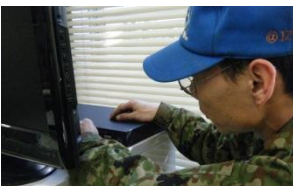
電話・システム移設工事風景
