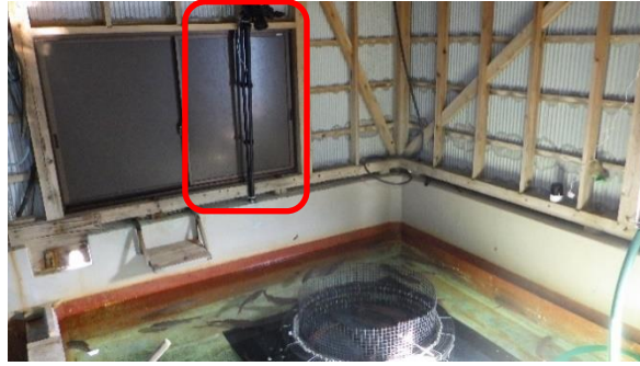
図 3.6-14 記録用カメラ設置状況
