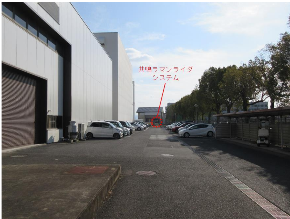
図 307 離隔距離 100 m の地点から見た共鳴ラマンライダシステムの設置状況
