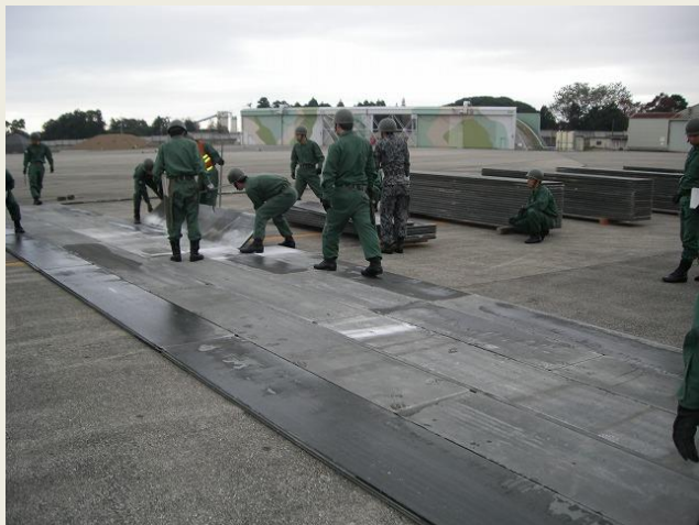
滑走路被害応急処置訓練1
