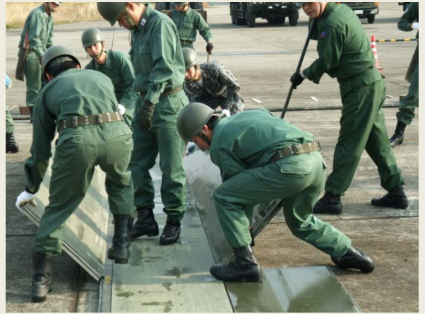
滑走路被害復旧訓練
