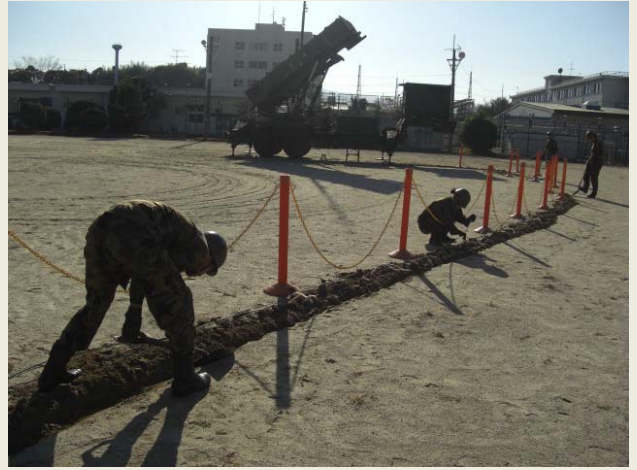
5高隊・光ケーブル埋設
