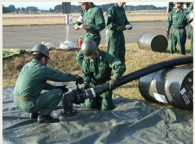
可搬型給油装置の設置
