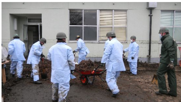
ガレキ除去作業
