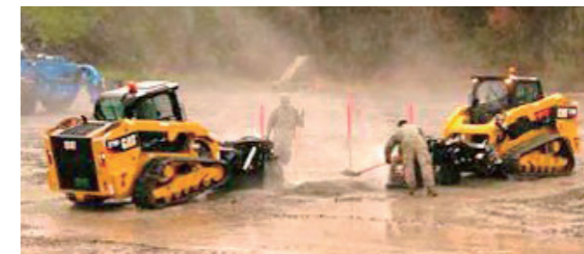
Équipement de rétablissement de piste endommagée
