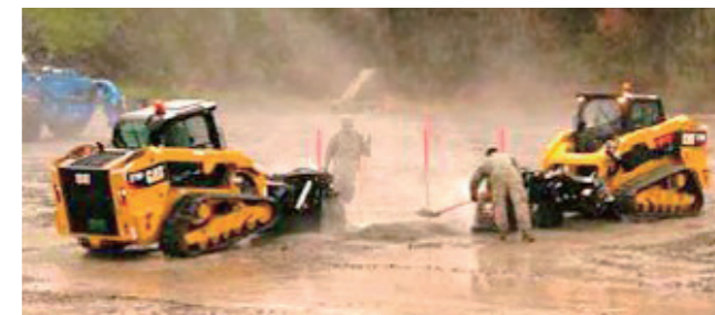
机场跑道损坏修复机械材料
